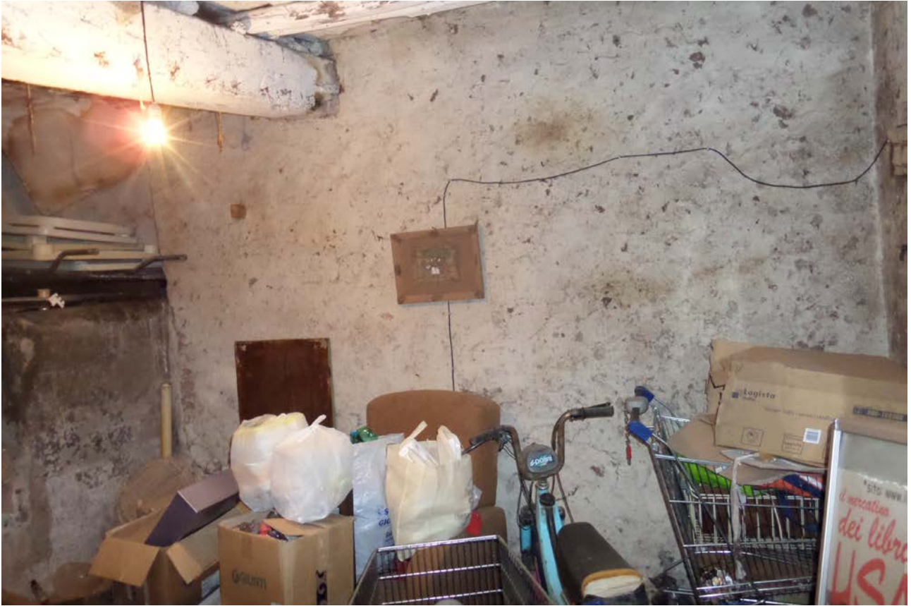
FOTO 3: Locale al piano terra
