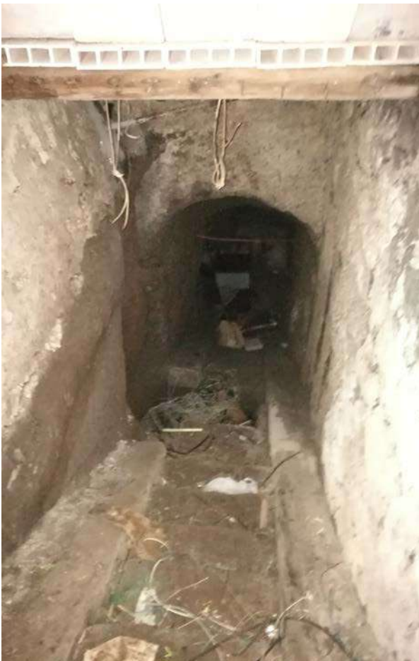
FOTO 4: Scala che porta al piano interrato
