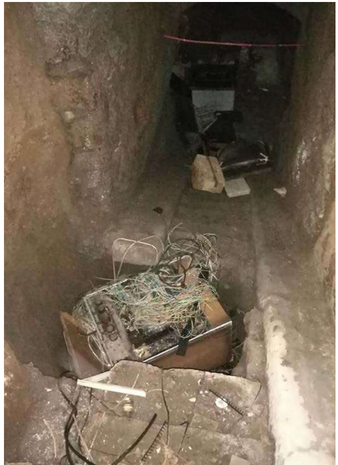
FOTO 5: Porzione danneggiata della scala
