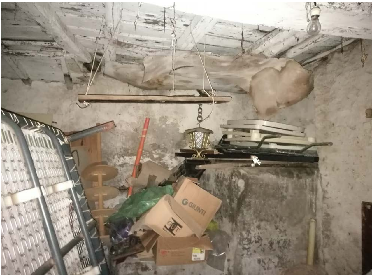
FOTO 2: Locale al piano terra
